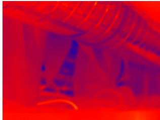
Allée chaude : perte au-dessus des baies
