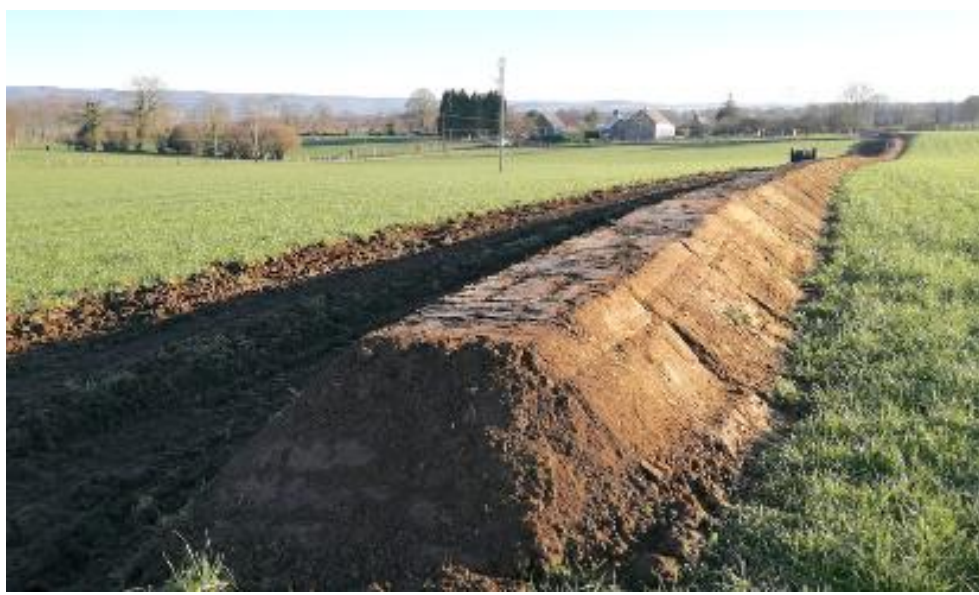
Plantation sur talus (SDeau50)
