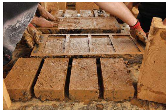
Maçonnerie terre crue
